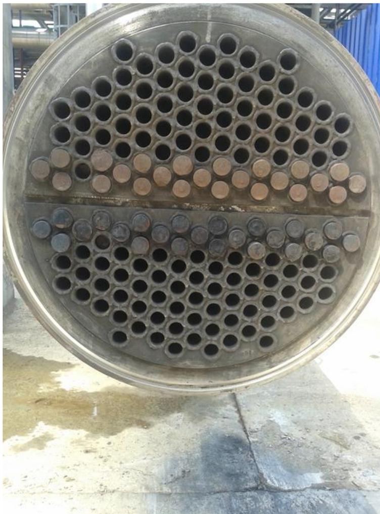
*Рис. 1. Общий вид трубной решетки с трубками, заглушенными по причине пропусков*
