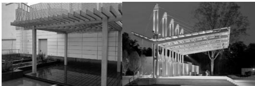
Рис. 3. Балочная система навеса
