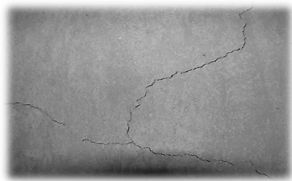
Рис. 1. Трещины шириной раскрытия более 0,3 мм по всей поверхности пенобетонных полов
