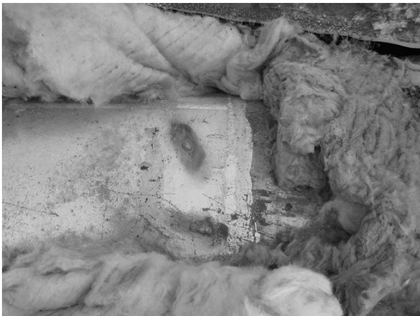
Рис. 6. Вид обследованного участка трубопровода после снятия изоляции
