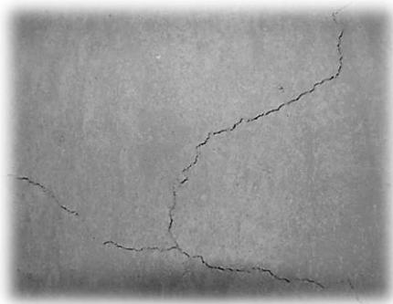
Рис. 1. Трещины шириной раскрытия более 0,3 мм по всей поверхности пенобетонных полов
